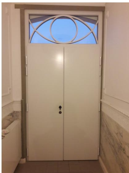
Les portes d'entrée hybrides couvrent toujours les deux côtés du vantail. Cela signifie qu'aucun profilé d'ouvrant et aucune parclose n'est visible, ni à l'extérieur ni à l'intérieur.
